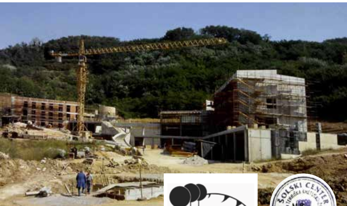
Gradnja šole (jesen 1997)
