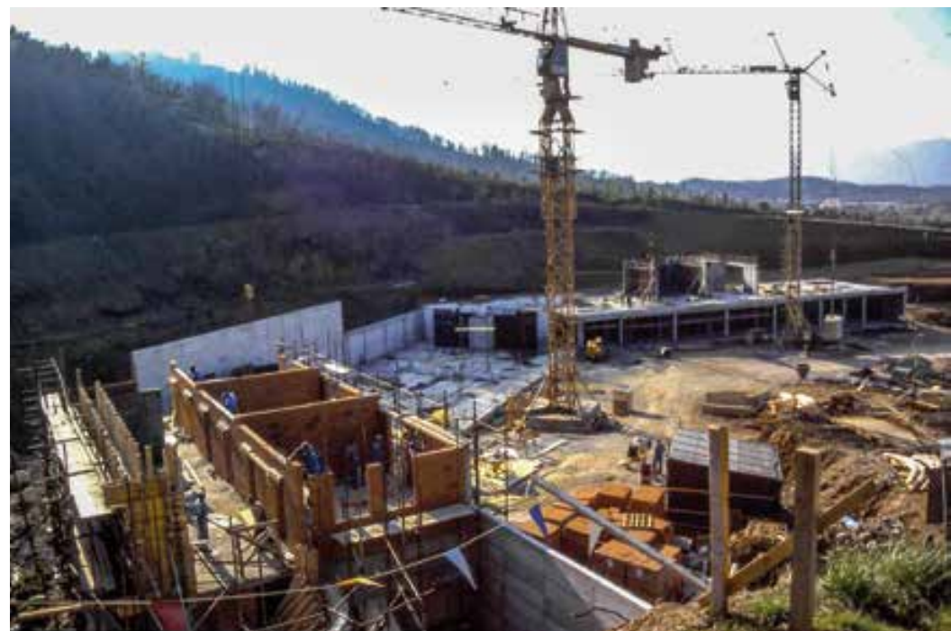
Gradnja šole (pomlad 1997)
