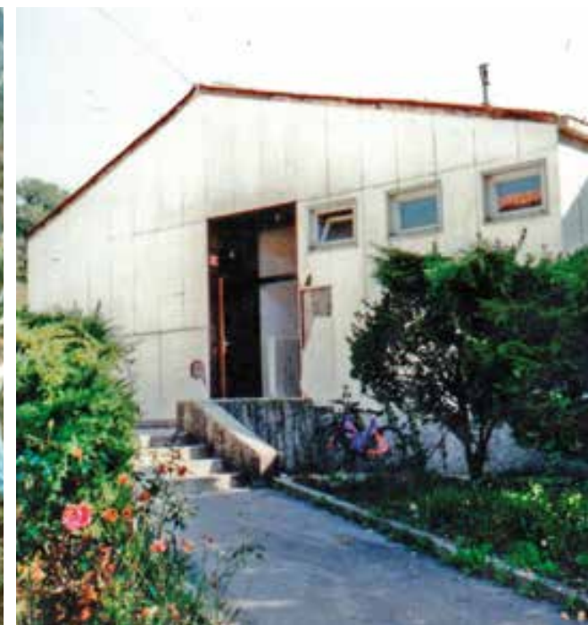
Stavba pri Kmetijskem zavodu v vse slabšem stanju
