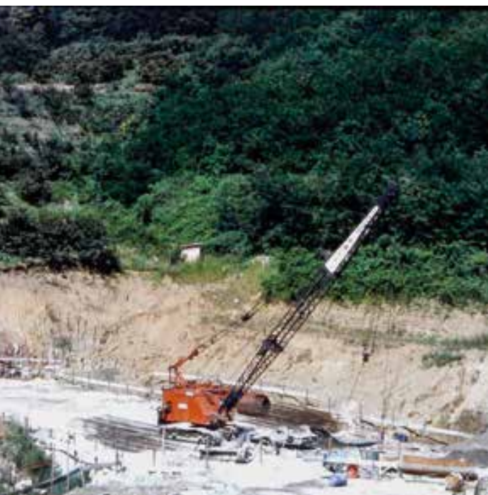
Temelji za novo šolo
